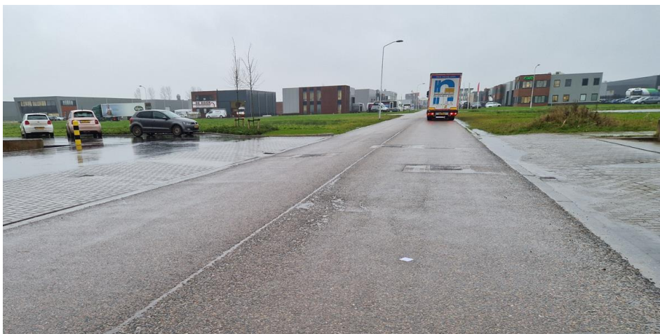
Figuur 3 Rafeling, openstaande middennaad en inspectieputten met elementen
